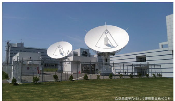
写真1 主局(左)と副局(右)に設置したアンテナ 各局に設置した、直径9mのKa/Ku帯共用アンテナ(写真提供HOPE)。
