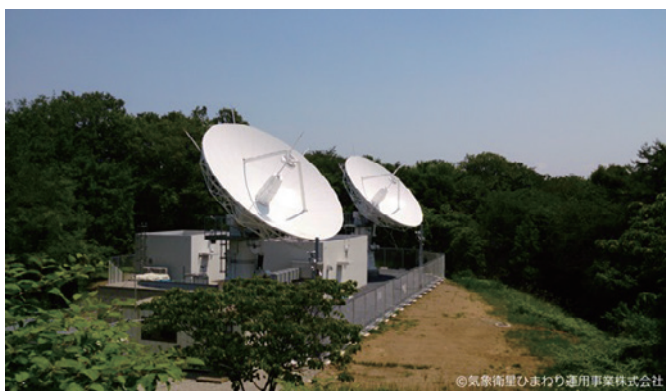
写真1 主局(左)と副局(右)に設置したアンテナ 各局に設置した、直径9mのKa/Ku帯共用アンテナ(写真提供HOPE)。
