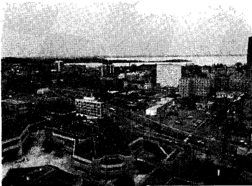
第8図 SSEC 屋上から北側を望む。遠くはメンドタ湖でその畔までウィスコンシン大学。この写真に写っているビルディングの大部分は大学の建物。メンドタ湖につきでている岬は Picnic Point と呼ばれており遊歩道がある。左下2階建 (屋上に三角形の屋根が見える) の建物が学生会館にあたる Union South。中央の道路は West Johnson Street で東行き (右方向) の一方通行路で4車線 1980年1月4日撮影。
