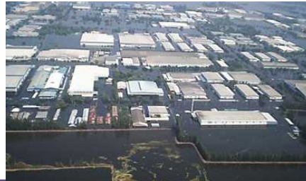
タイ ロジャナ工業団地の浸水状況 (2011年10月~11月) 出典：国土交通省 水防の基礎知識
