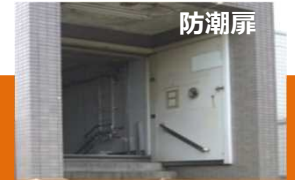
地下鉄出入口の浸水対策
