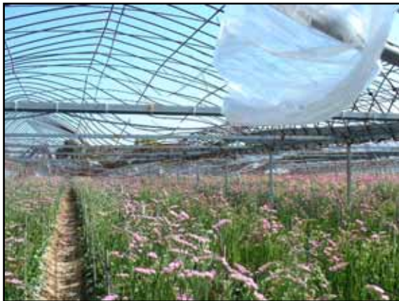
写真 3 押しつぶされてビニールが飛ばされた ビニールハウス
