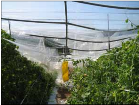
写真 1 押しつぶされたビニールハウス内部
