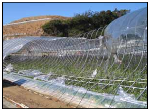
写真 6 側面がつぶされたビニールハウス
