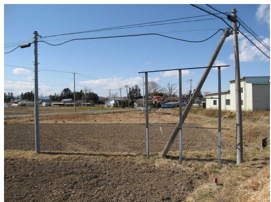
吹き飛んだホームセンターの看板
