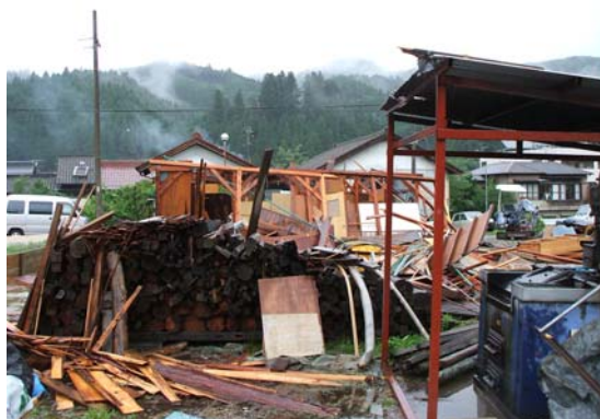
② 木造・トタン屋根駐車場倒壊 (南から撮影)
