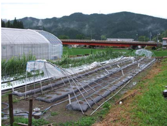
① ビニールハウス倒壊 (南から撮影)
