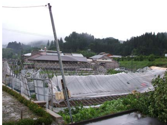
④ ビニールハウス及び電柱傾く (北西から撮影)
