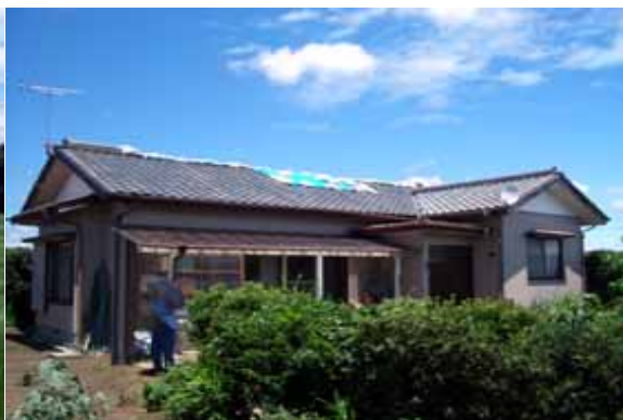
屋根の南側の状態
