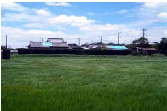
北側の屋根（左は瓦、右はトタン）破損
