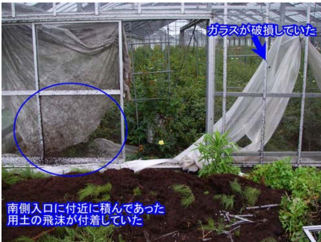
被害ガラスハウス
