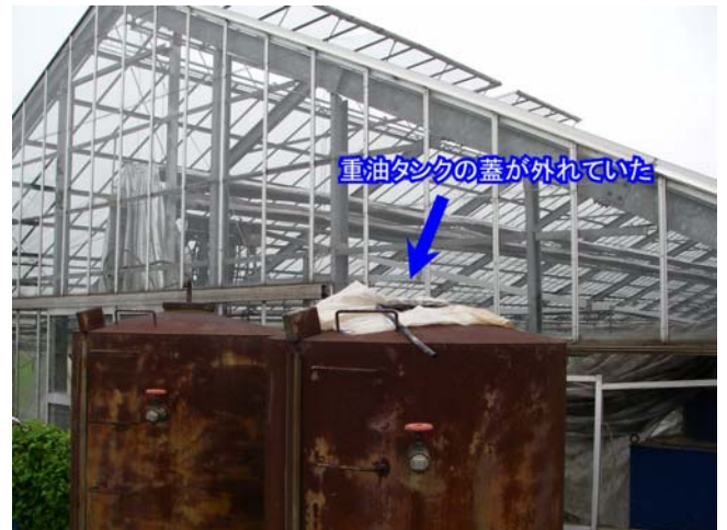
被害ガラスハウス重油タンク
