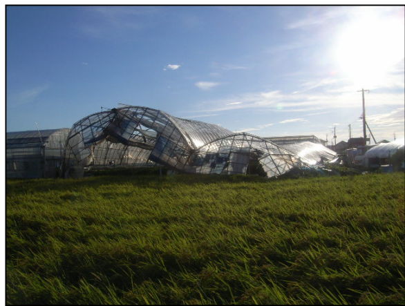
② 倒壊したビニールハウス 周辺の稲は南方向に倒される。
