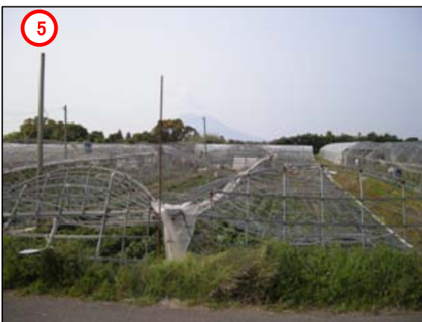
ビニールハウスが北側に倒壊
