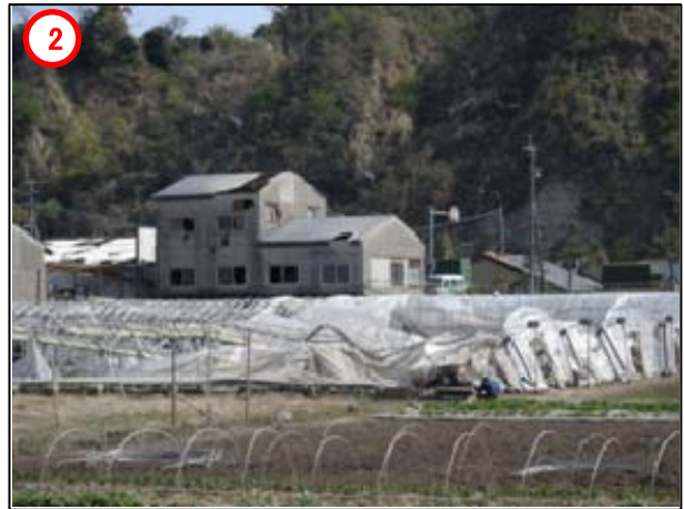
ビニールハウスが北側に倒壊
