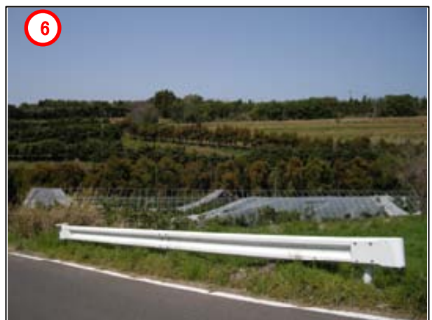
ビニールハウスのビニールが剥離
