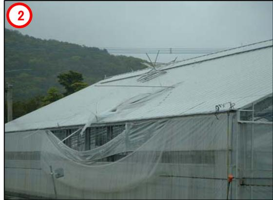
全長 37m のビニールハウスの屋根の天窗が破損し東側のビニールが 13m に渡りめくれている。
