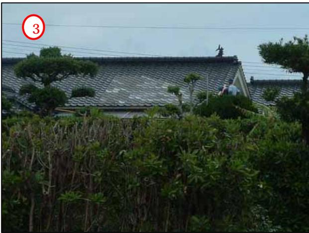
屋根瓦が東方向へ飛散
