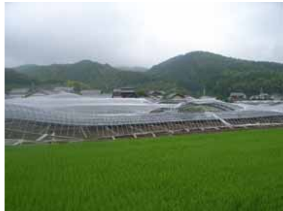
写真の撮影場所 全体にわたって押し倒され、 ビニールも剥ぎ取られている。
