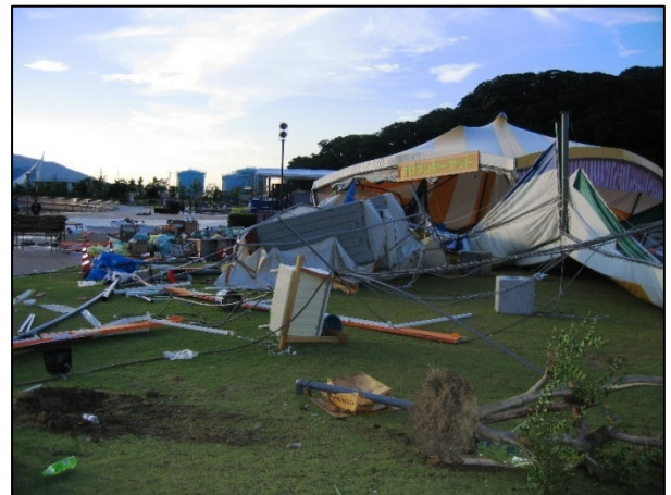
② 飛ばされ倒壊したテント （南から撮影）
