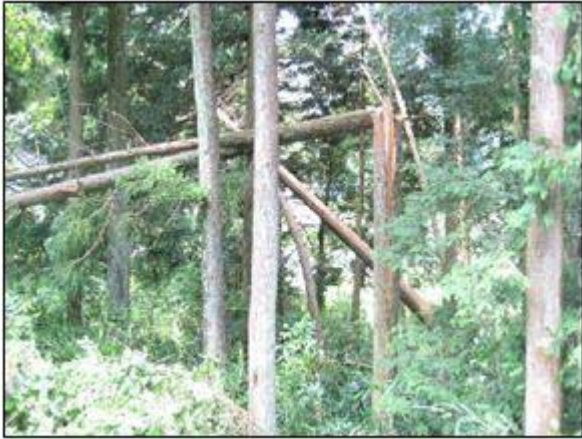
①幹が折損した樹木（南側から撮影）
