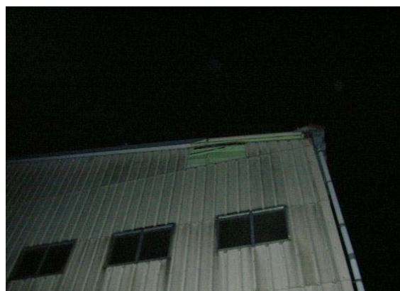
② 鳥取市青谷町青谷 事業所の鉄製の屋根がめくれて、穴が開いている。
