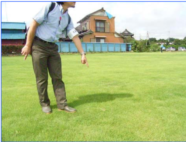
③: 被災家屋から南東方向30～40メートル 瓦の一部が落ちていた位置。中央奥が被災家屋。
