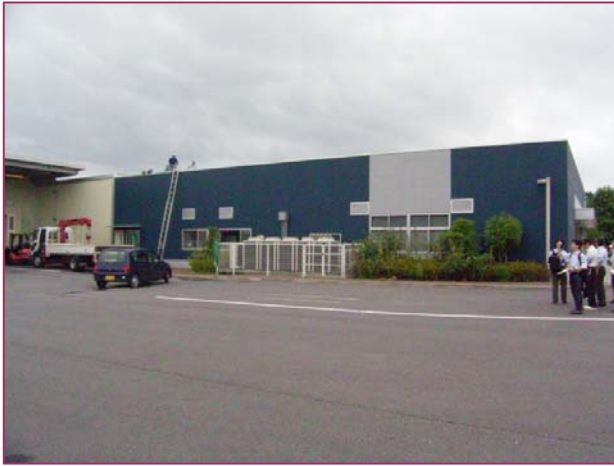
①：飛ばされたプレハブ小屋の落下地点(会社事務所屋上中央部でプレハブ小屋は撤去済み)
