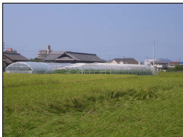
④ 丸亀市中津町付近 北東から南西方向に設置されたビニールハウスの南西側の骨組みが曲がり崩れる
