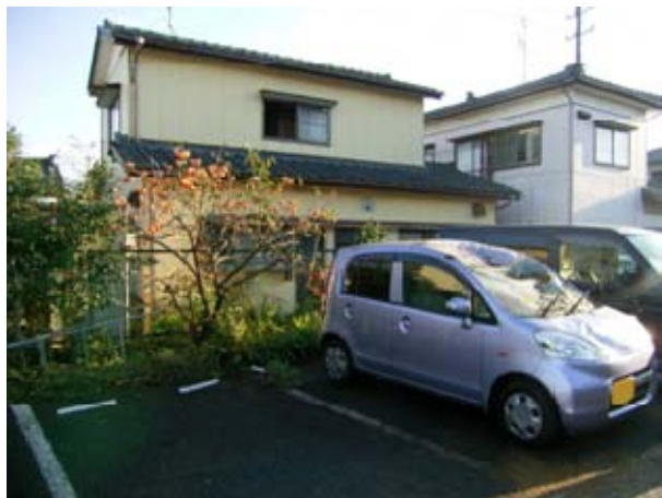
②トタン屋根飛散により破損した軽自動車 2階ガラス破損 (北東から撮影)
