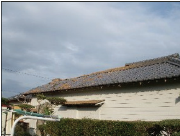
③ 住家屋根瓦の飛散（南西から撮影）
