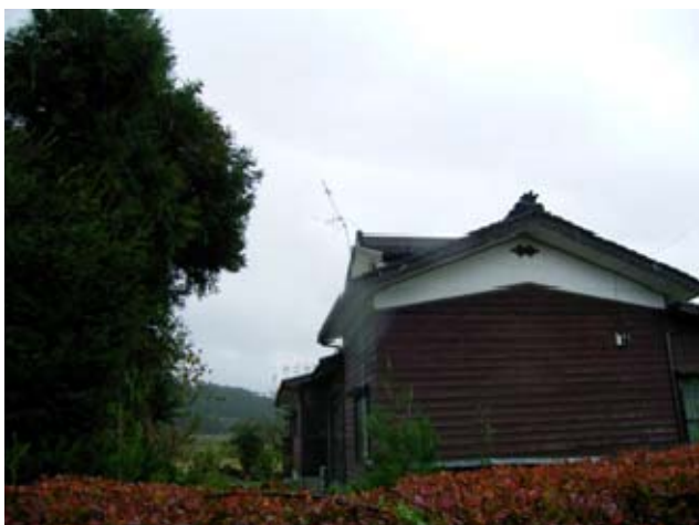
③アンテナの曲がり（西から撮影）
