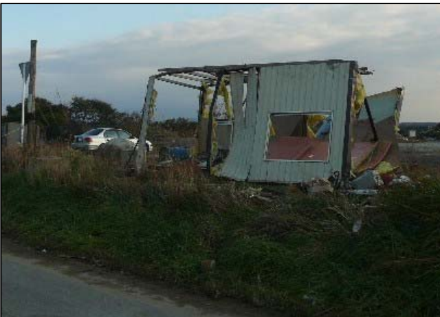
③ 転倒したコンテナ【北西から撮影】 北方向に転倒し道路を塞いだ。 ※写真は道路上から撤去後
