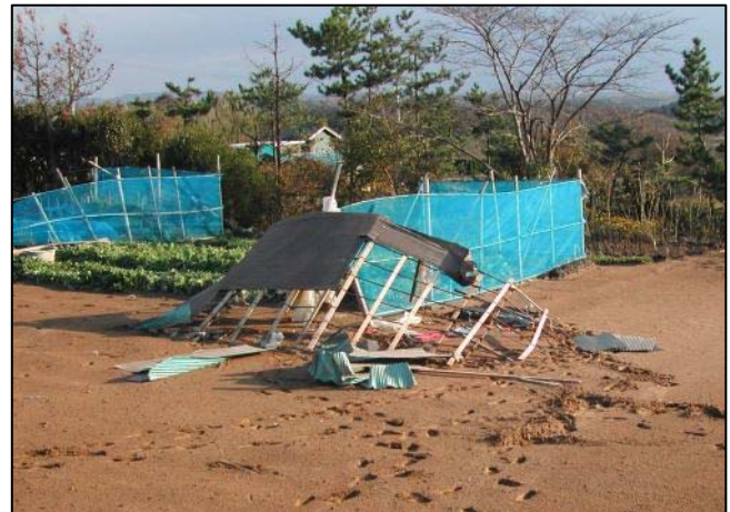
④ 飛ばされた農具小屋【北西から撮影】 西へ約5m飛ばされた後、南東へ約60m飛ばされた。
