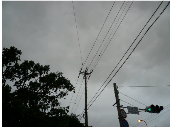
H-4 ネットが絡まっていた電信柱（撤去済み）
