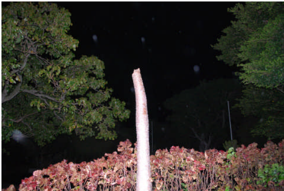
H-5 道路側へ折れた樹木（飛散部分は撤去済み）
