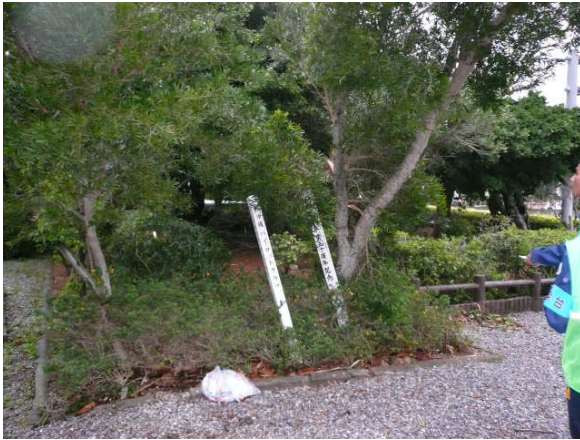
H-3 西向きに折れた枝と傾いた標示
