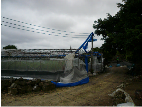
H-1 飛散したネットが絡まった電信柱
