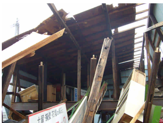
写真 06 農機具倉庫内部
