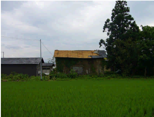
写真08 納屋北側からの全景
