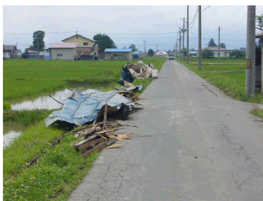
写真 05 農機具倉庫の飛散した屋根（回収後）
