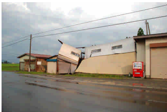
写真 01 農機具倉庫（北側） （被災直後に住民が撮影）
