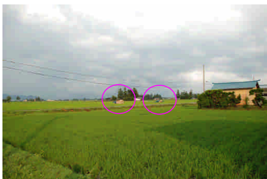
写真 02 農機具倉庫の南東側水田 （○の囲みは飛散した屋根） （被災直後に住民が撮影）
