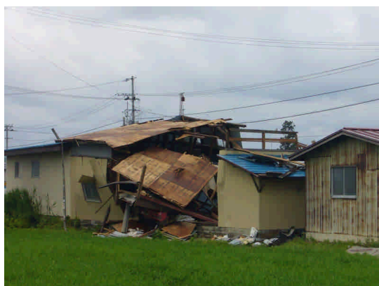
写真 04 農機具倉庫（南東側）
