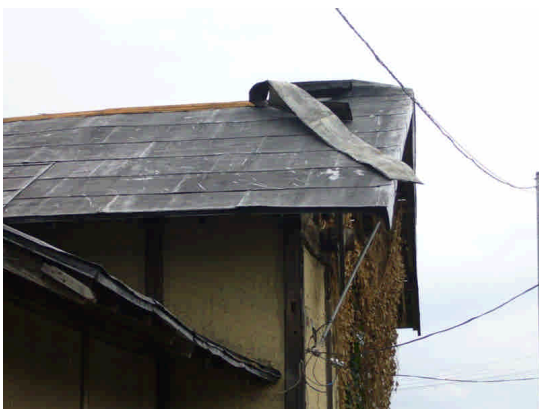
写真09 納屋の屋根の南側
