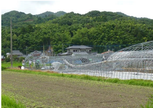
①北東側から撮影
