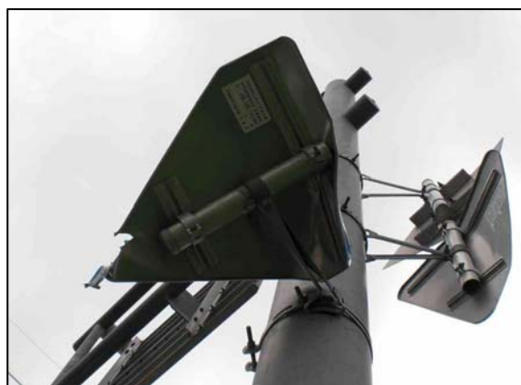
「写真③の道路標識」の真下からの写真
