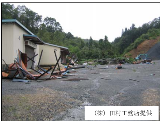
写真① プレハブ倉庫が全壊（20 日撮影）
