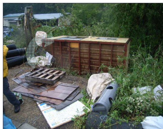
写真④ 横転したコンテナハウス
