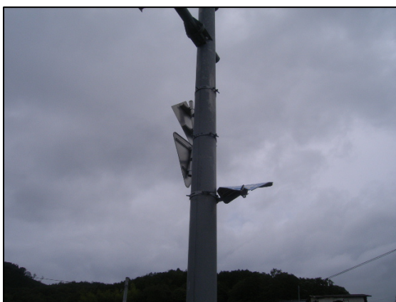
写真③ 一番下の交通標識が上向きにねじ曲げ
