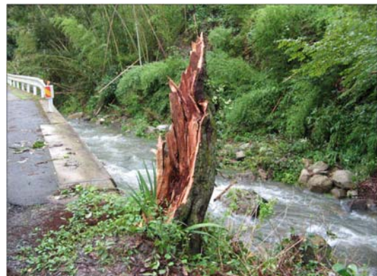
写真②（根本付近から）樹木が損壊
