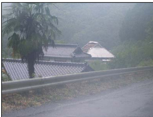
写真① 屋根が一部損壊（反対側の屋根も一部損壊）
