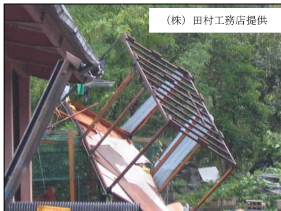
写真② 飛ばされたコンテナハウス（20 日撮影）
