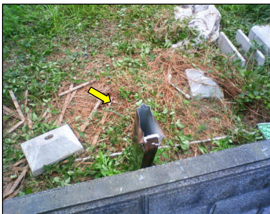
② 丹波市青垣町佐治地区 破損したカーポートの支柱
