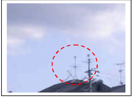
⑩ 京都市伏見区日野西大道町 アンテナが北の方向に倒れる。
