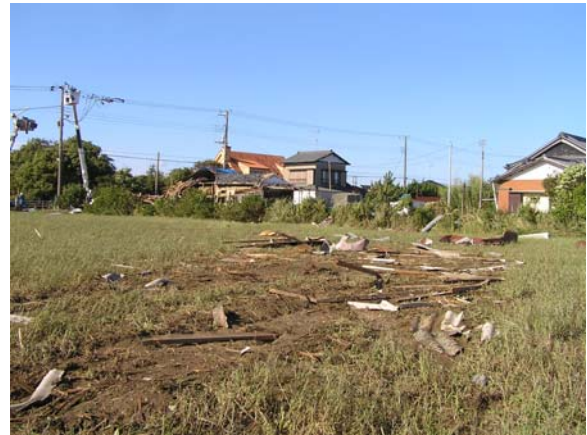
② トタン・スレート屋根の飛散 （南南東から撮影）
