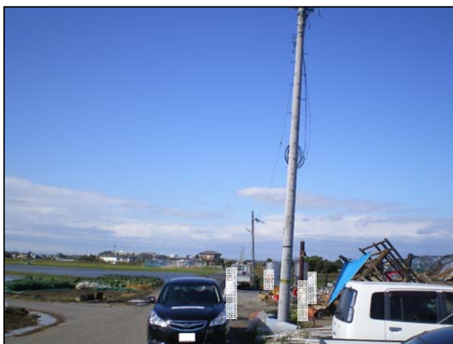
③ ビニールハウス脇電柱の傾倒・断線 （南から撮影）
