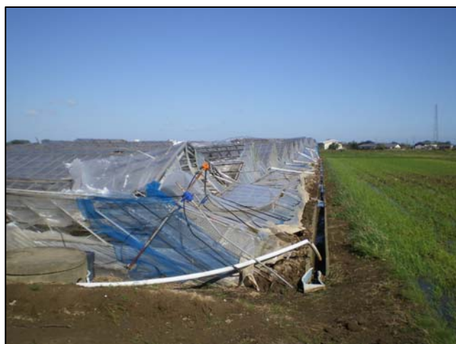
④ ビニールハウスの倒壊 （西から撮影）
