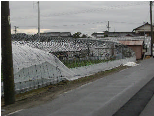
⑤ ビニールがめくれ上がったビニールハウス
