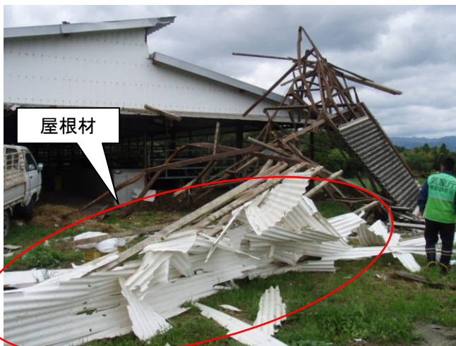
屋根部分 (鉄骨) と屋根材 (塩化ビニール波板)
