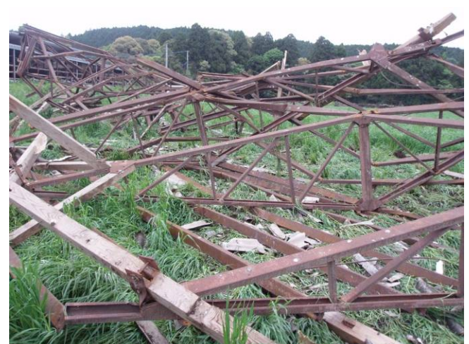
屋根部分 (鉄骨)
