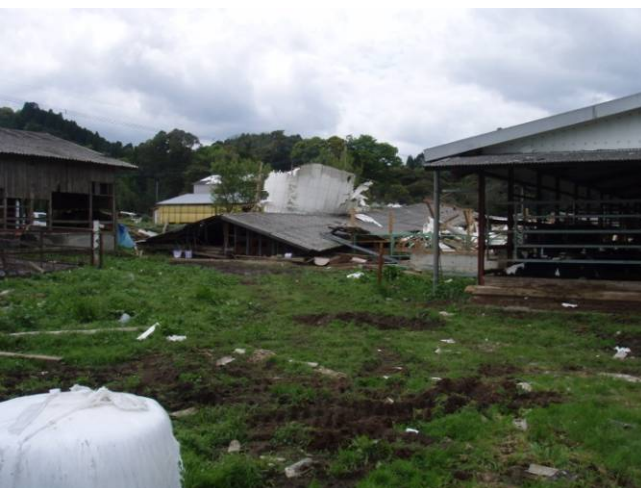
⑤倒壊した牛舎（東から撮影）
