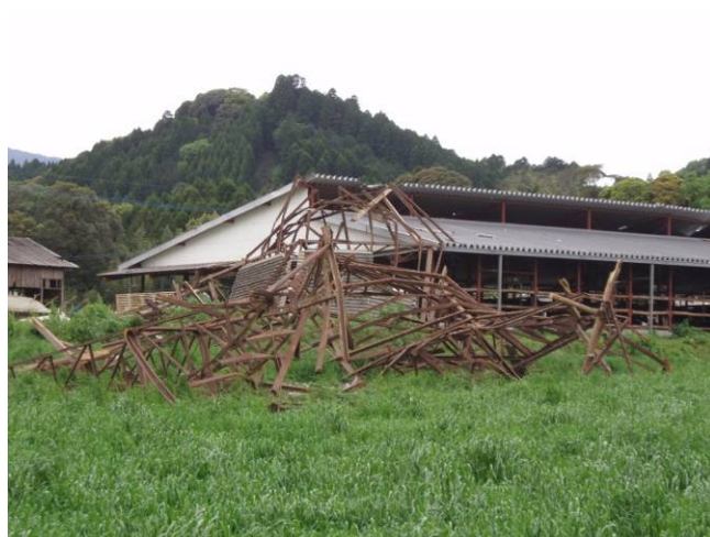
屋根部分 (鉄骨)
