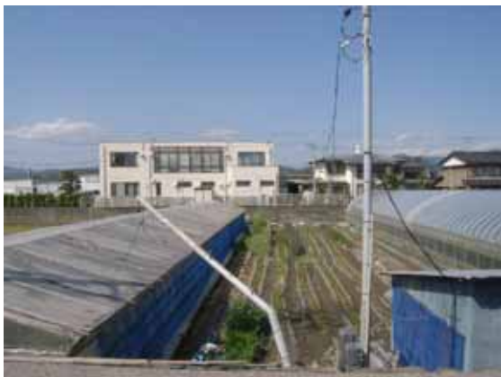
図 9-1 写真の撮影場所 手前の電柱が北西に折れ曲がっている。
