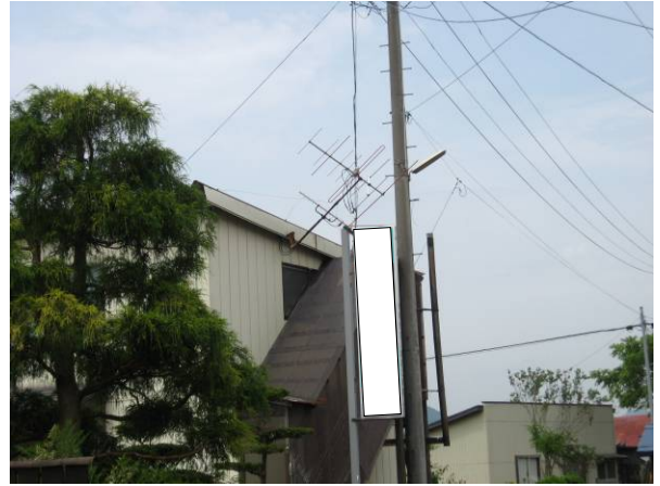
⑩ 倒れかかったテレビアンテナ （南から撮影）
