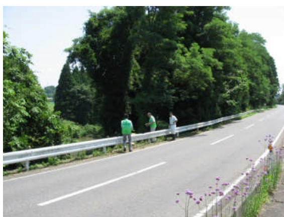
⑥ 木が倒れ道をふさいだ地点。木は切断され道路から撤去されている。（北西側から撮影）
