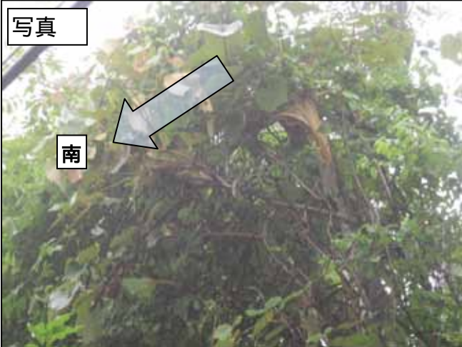
写真 道路西側 道路上、北東位置より南西方向に撮影 南方向に枝が折れ曲がっている
