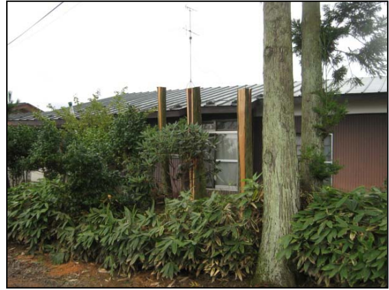
⑧ 折れた杉の木の跡、伐採撤去後 (西北西から撮影)
