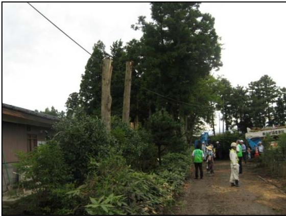
⑦ 折れた杉の木の跡、伐採撤去後 (東から撮影)
