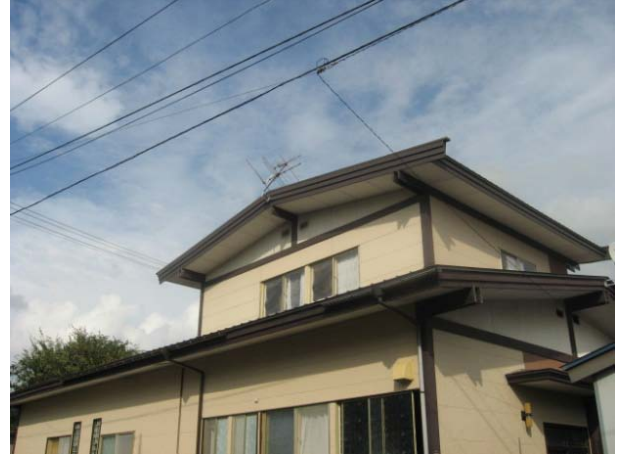
⑩東方向へ倒れたアンテナ (南西方向から撮影)
