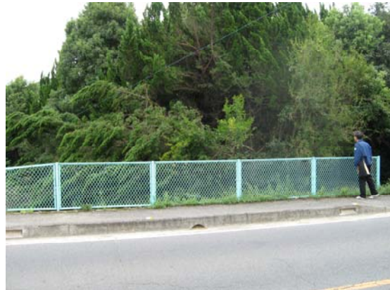
図 7-13 写真撮影場所⑬ 樹木が北方向に倒れた。
