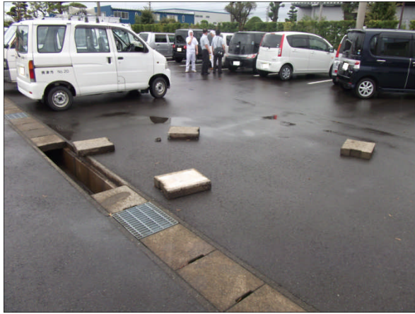
③ 側溝の蓋が飛散
