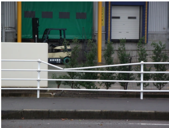
① 工場で作業中に積み上げていたコンテナが突風で落下し、破損したフェンスとガードレール
