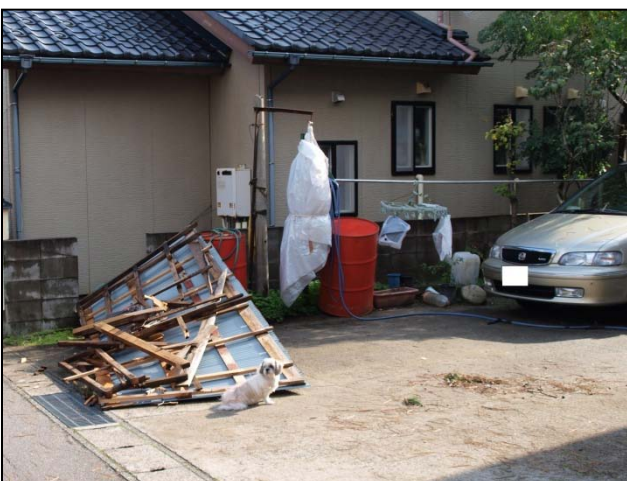
⑤ 200 m飛んだトタン屋根 (西から撮影)
