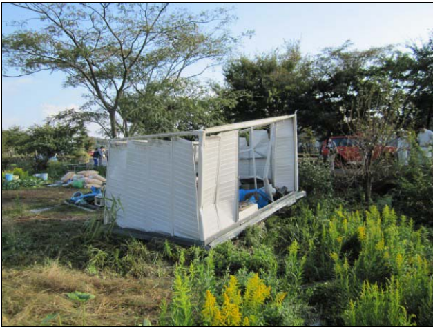
③ 20 m飛んで破損したプレハブ (南西から撮影)
