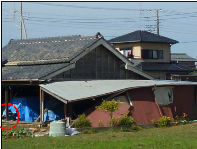
③傾いた物置の屋根 (赤い円は写真④の位置)
