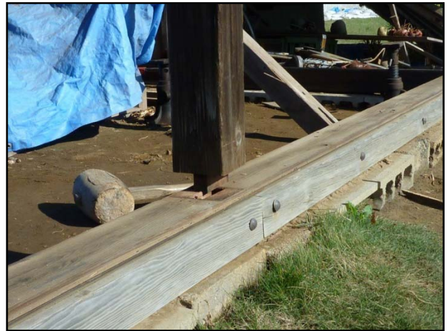
④浮き上がった物置の柱
