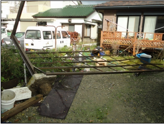
①カーポートの倒壊
