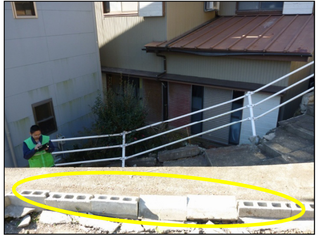
⑤飛ばされた物置跡と飛散物(物置) による柵の損壊跡
