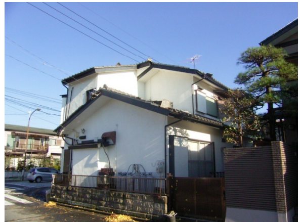
② 瓦の破損（南西から撮影）
