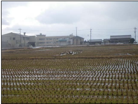
⑨200m離れた田に落下した工場屋根の一部 【北東から撮影】
