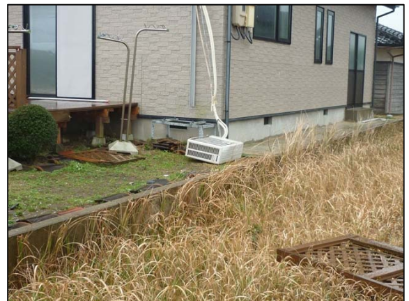
⑩飛散したウッドデッキの一部と倒れたエアコン室外機 【東から撮影】
