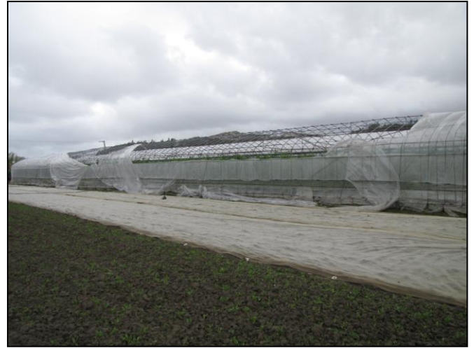
⑥ ビニールハウス1棟 ビニールの破れ
