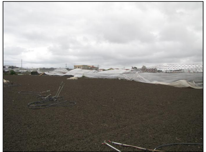
② ビニールハウス5棟 損壊
