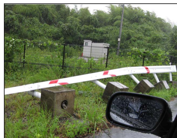
⑥ 亀山市 ガードレールが北側に横転 レールに擦痕なし （南南西側から撮影）
