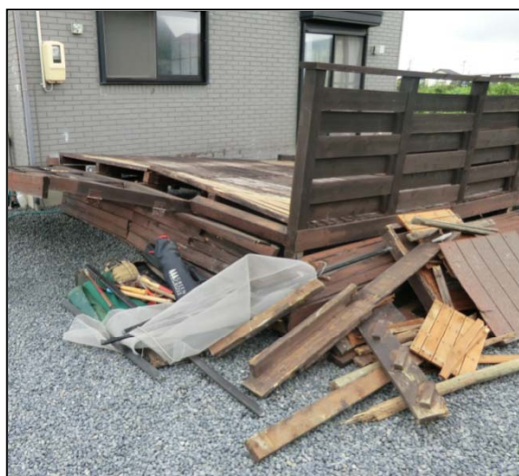
② 津市 南側にウッドデッキ倒壊 周辺の木材は倒壊に伴い散乱した ものを収集 （南側から撮影）
