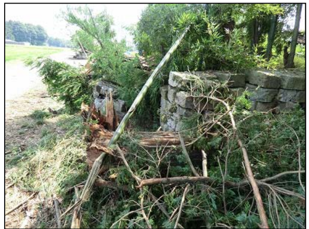
④ 倒れた杉の木と竹 (北から撮影)
