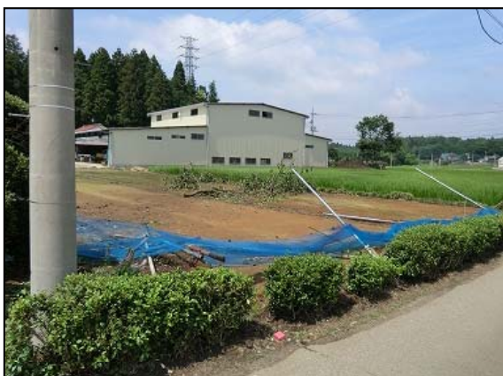
⑤ 北北東に倒れた農業用ネットと飛散した枝 (南西から撮影)
