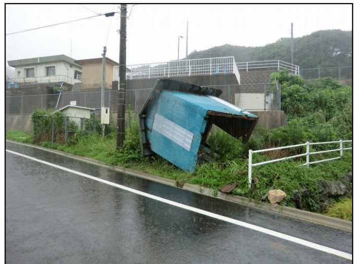
⑥道路上に飛ばされた小屋(写真は片付けられた後) (撮影方向:北)
